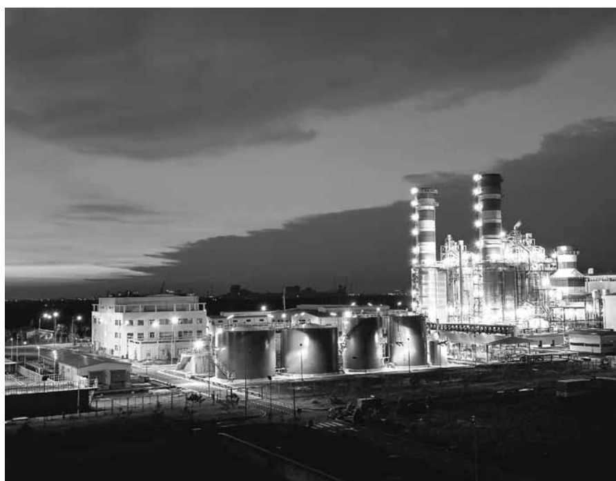
▲ Công nghệ của Siemens giúp Nhà máy điện chu trình hỗn hợp Nhơn Trạch 2 đạt hiệu suất trên 57% - mức hiệu suất cao nhất Việt Nam hiện nay
